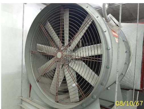
การระบายอากาศวิธีกลของบันไดหนีไฟ และลิฟต์ดับเพลิง
